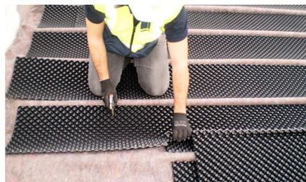
A placa drenante Floradrain® FD 25-E foi cortada em tiras e colocada entre as concavidades da chapa metálica.
